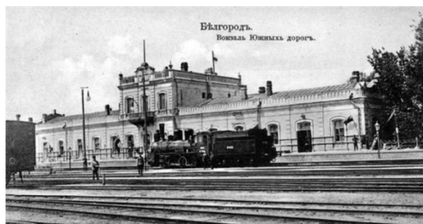
Рис. 3. Здание железнодорожного вокзала в Белгороде после реконструкции. Восточный фасад. Архивное фото 1911 г.
