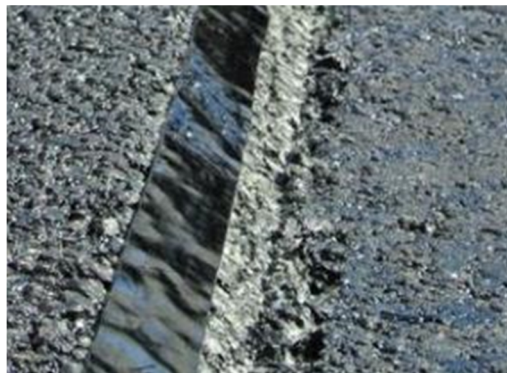
Рис. 2. Стыковочная лента на холодной кромке, ранее уложенной полосы покрытия
