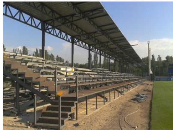
Рис. 1. Конструкция стационарного покрытия над трибунами стадиона ФК «Олимпик»
