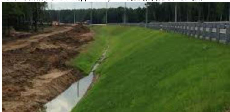
Рис. 1. Укрепление насыпи засевом трав
