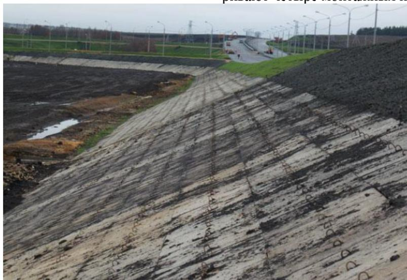
Рис. 4. Укрепление насыпи бетонными плитами
