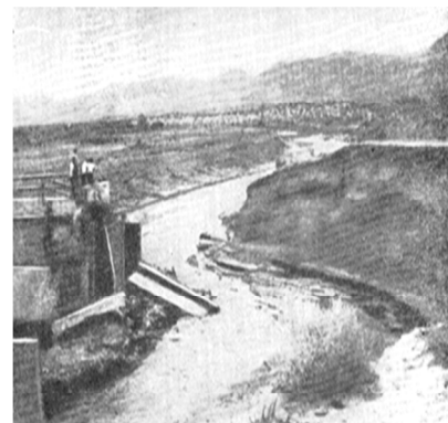
Рис. 3. Разрушение земляной плотины Роджерс Дам [9]
