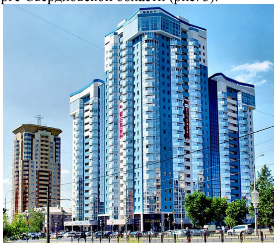
Рис. 3. 25-ти этажный современный жилой комплекс «Московский» в Екатеринбурге, построенного на основе металлокаркаса
