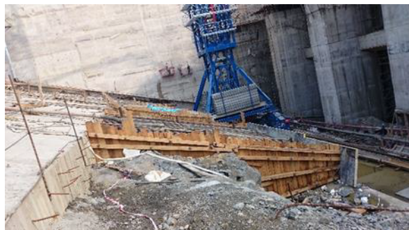
Рис. 6. Участок наклонной плоскости, подготовленный к бетонированию, а также забетонированный предыдущий блок с арматурными выпусками
