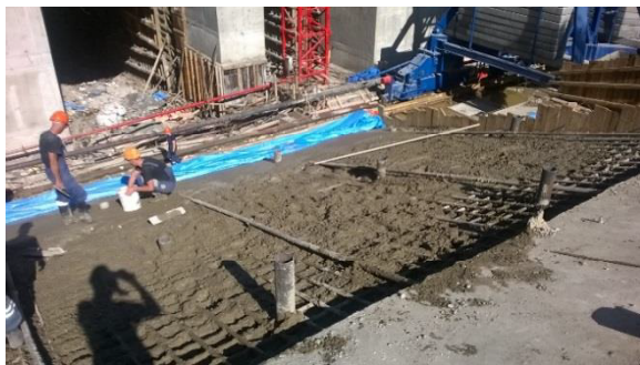
Рис. 8. Бетонирование блока. Процесс создания ровной поверхности
