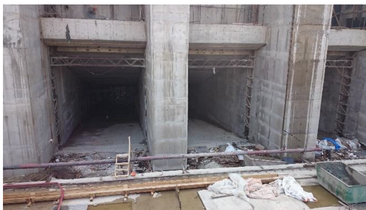
Рис. 2. Проходные отверстия блока агрегатов с генераторами
