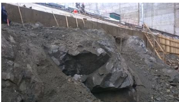
Рис. 3. Неочищенная скала от грязекаменной массы. Средняя часть наклонной плоскости
