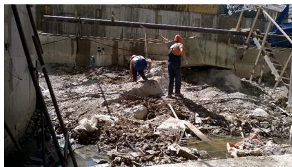
Рис. 4. Неочищенная скала от грязекаменной массы и строительного мусора. Нижняя часть наклонной плоскости прямо над верхним уровнем
