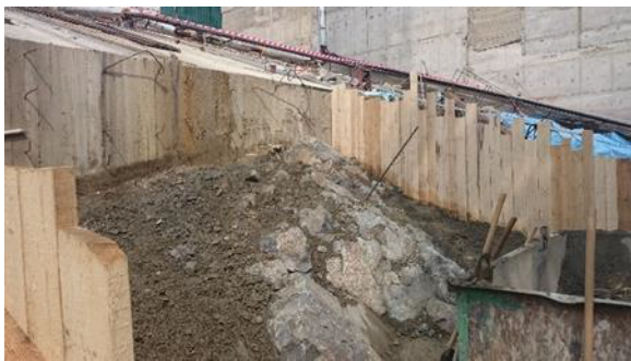
Рис. 5. Установленная опалубка на заключительном этапе очистки скалы
