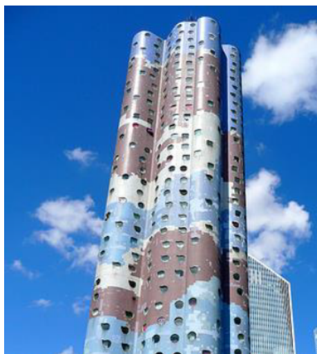
Рис. 3. Ф. Риети. «Облака» – тема атектоничной суперграфики в квартале «Стержни Дефанса» в пригороде Парижа, 1972
