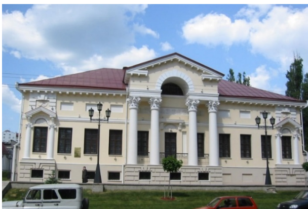
Рис. 1. Дом купца Селиванова. Главный фасад
