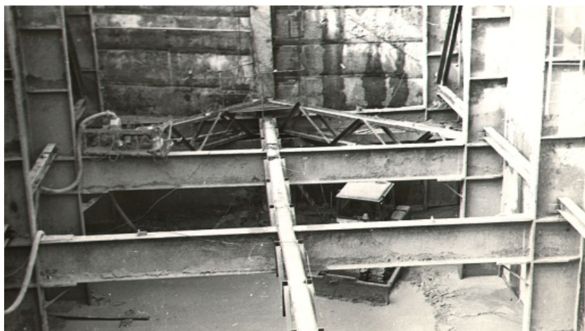
Рис. 4. Открытые рамы заглубленного сооружения перегрузочного узла № 8 со средним ригелем и временными распорками. Ниже бульдозер разрабатывает грунтовое ядро
