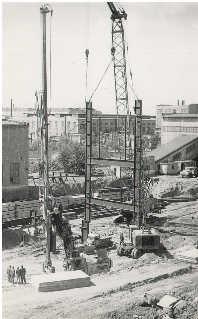
Рис. 3. Монтаж рамы в траншею при строительстве ПУ-8
