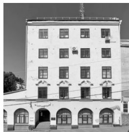
Фото: Телефонная станция. Выполнила: Быстрова У.И. Дата: 15.01.2025 г.
