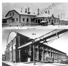
Фото: Комплекс производственных и складских построек ж/д станции 1900 г. Дата обращения: 15.01.2025 г. [Источник: https://pastvu.com/ ]
