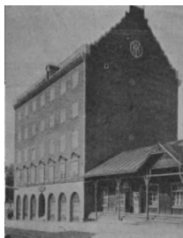
Фото: Телефонная станция 1910 г. Дата обращения: 15.01.2025 г. [Источник: https://pastvu.com/ ]
