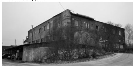
Фото: Выборгский мясоперерабатывающий комбинат. Выполнила: Быстрова У.И. Дата: 15.01.2025 г.
