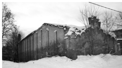
Фото: Выборгский мясоперерабатывающий комбинат. Выполнила: Быстрова У.И. Дата: 15.01.2025 г.
