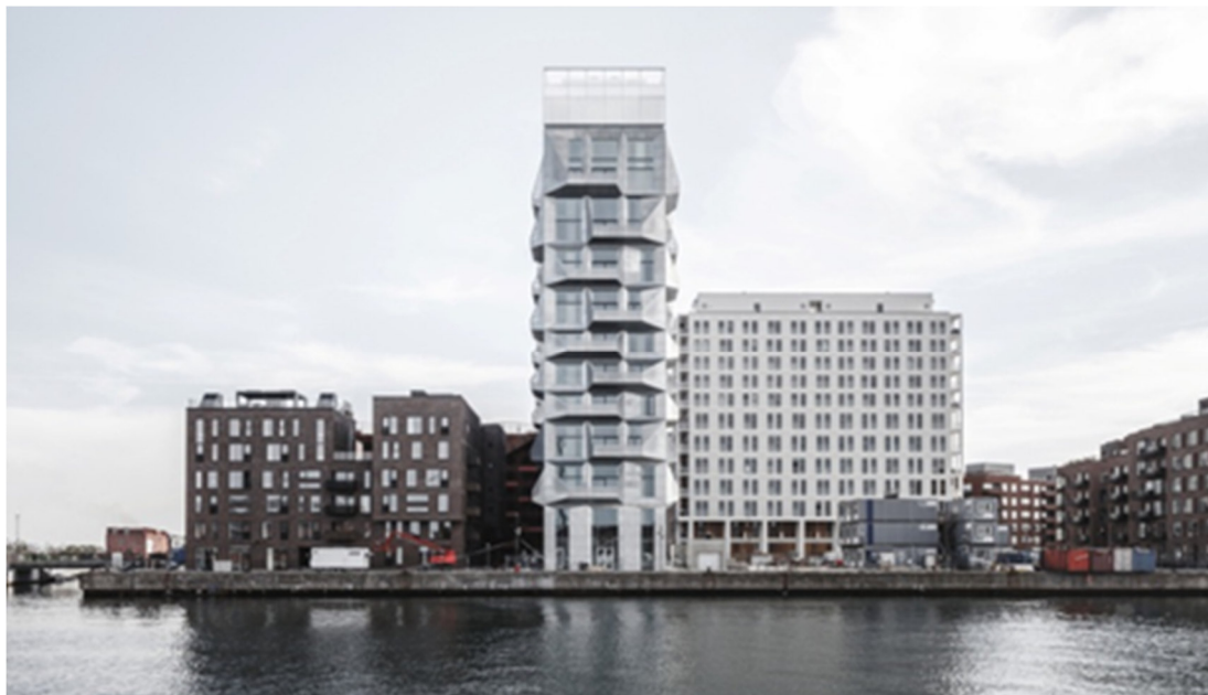
Рис. 4. Зерновой элеватор после реконструкции, г. Копенгаген, Дания
