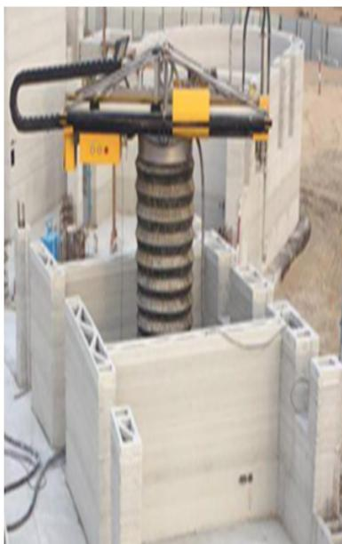
Рис. 3. Промышленный 3D-принтер для высотного строительства
