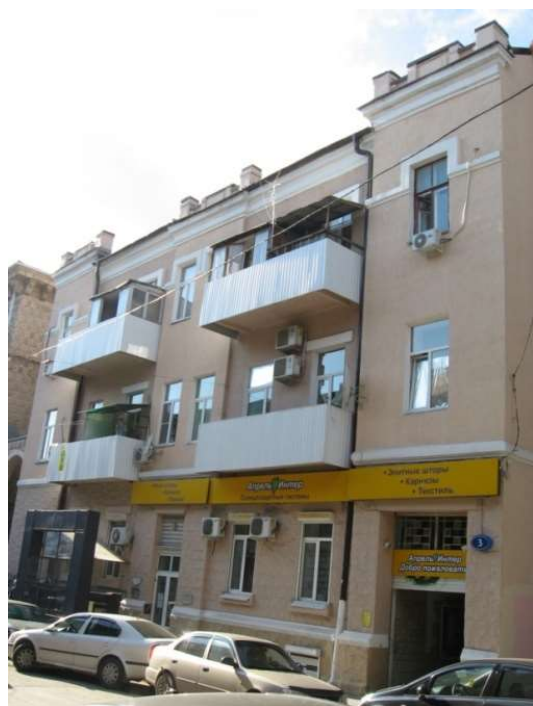
Рис. 3. Жилое здание по адресу: ул. Суворова, 3 (фото автора)
