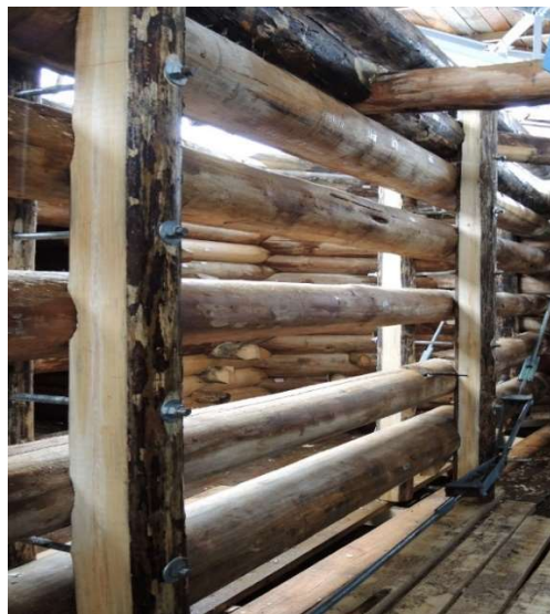
Рис. 2 Монтаж шпренгельной системы на четвериковых балках церкви Преображения Господня (фото автора)
