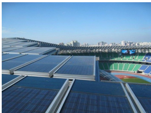
Рис. 5. Покрытие главного стадиона. Тайвань
