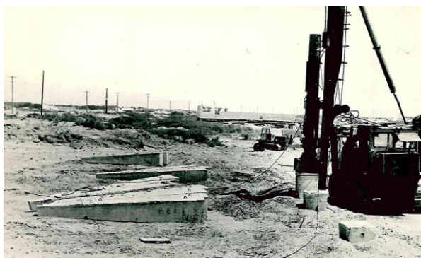
Рис. 1. Забивка пирамидальных свай на тепличном комбинате в г. Курске
