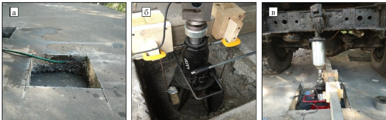
Рис. 3. Проведение штамповых испытаний земляного полотна из ЗШС: а – водонасыщение золошлаковой смеси перед испытанием; б – установка нагружающего устройства; в – измерение осадок штампа при нагружении
