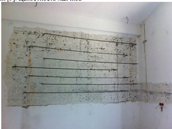
Рис. 9. Выполненное на объекте усиление стен с трещинами
