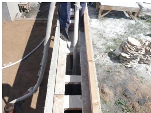
Рис. 5. Процесс заливки пеногипсовой смеси в конструкцию стен
