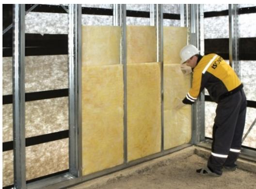
Рис. 2. Конструкция ЛСТК с применением минеральной ваты
