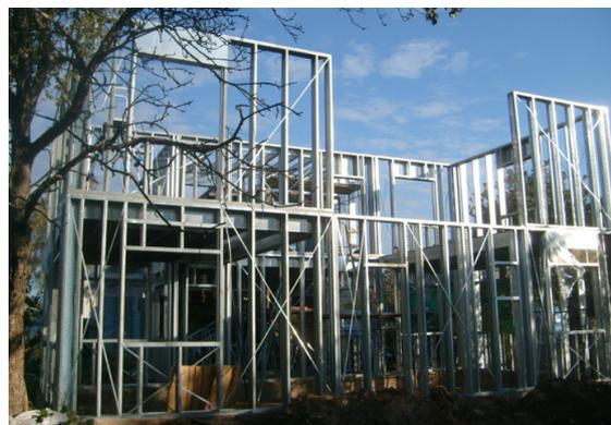
Рис.1. Монтаж ЛСТК при возведении здания
