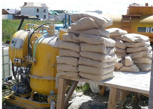
Рис. 4. Эжекторно-турбулентная установка на строительной площадке
