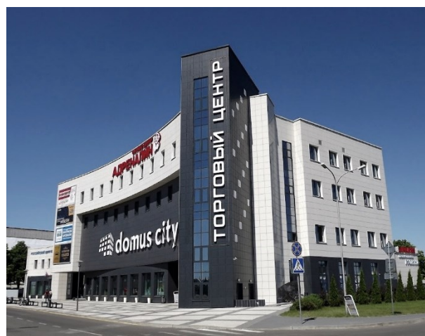
Рис. 4. Здание торгового центра «Domuscity», облицованное керамогранитными плитами, Беларусь [ http://directmap.by ]
