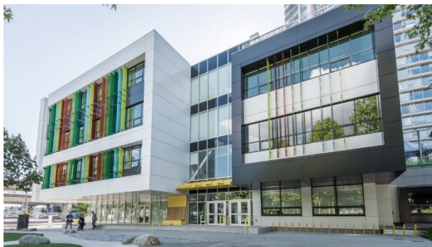
Рис. 5. Здание школы начальных классов, облицованное алюминиевыми композитными панелями, Канада [http://bkl.ca]
