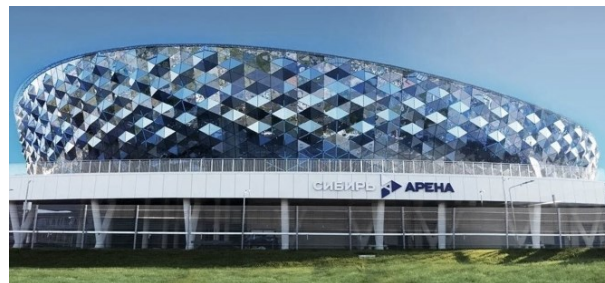
Рис. 6. Здание ледового дворца спорта, облицованное алюминиевыми сотовыми панелями, Россия [https://kp.ru]
