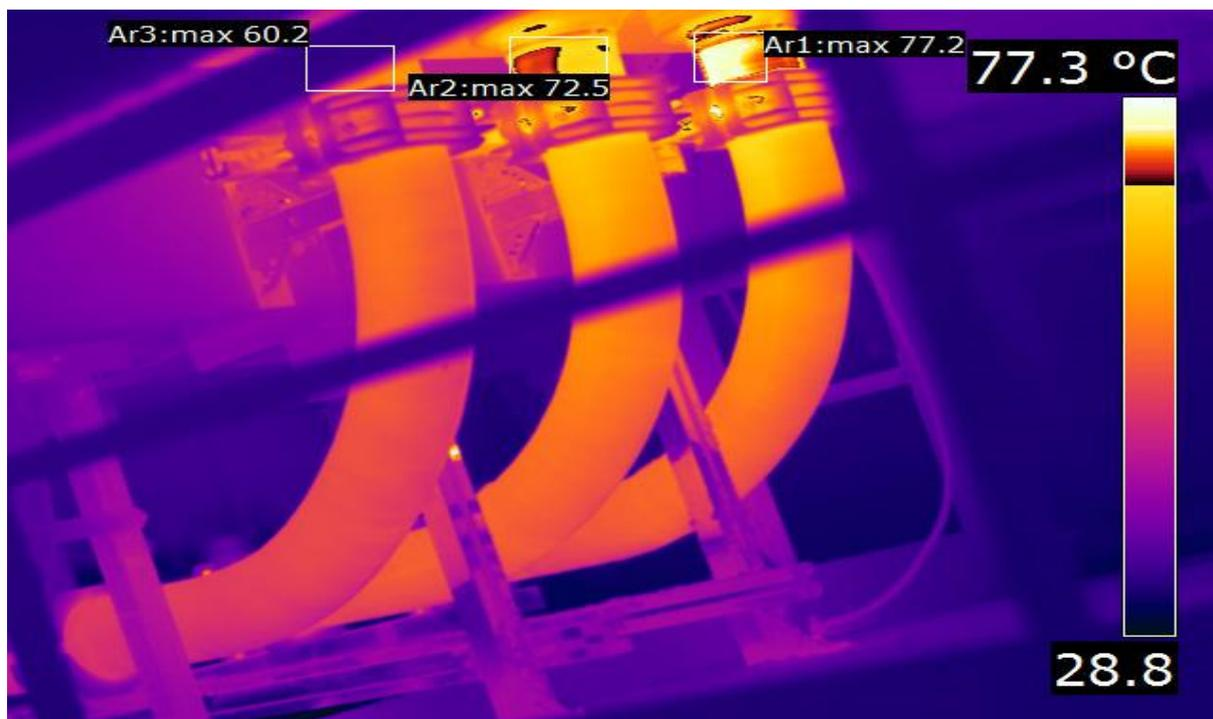
Рис. 3. Термограмма вертикального токопровода напряжением 10 кВ турбогенератора № 2
