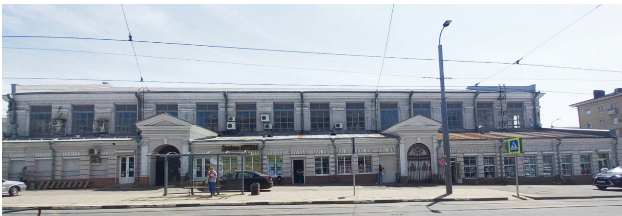
Рис. 4. «Павильон крытого рынка». Вид здания с северной стороны. Фото Петрусенко Ю.В., 2023 г.
