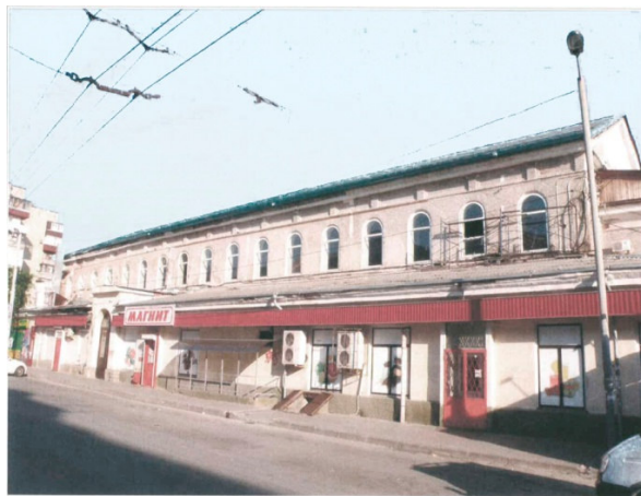
Рис. 2. «Павильон Нахичеванского рынка». Общий вид северного фасада [18]. 2017 г., фото до реконструкции
