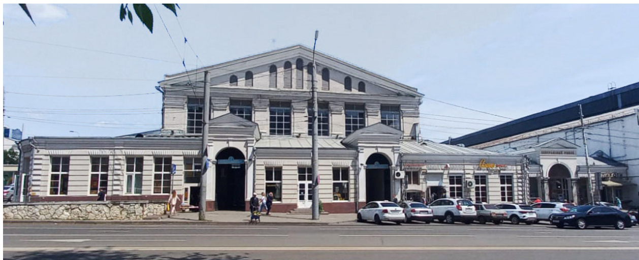
Рис. 3. «Павильон крытого рынка». Вид здания с северо-западной стороны. Фото Петрусенко Ю.В., 2023 г.
